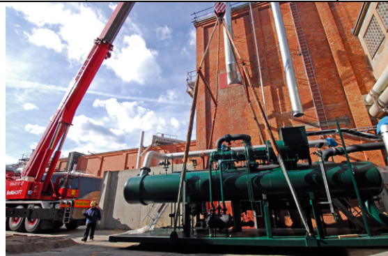
En Powerbox installeras vid Aspa Bruk
